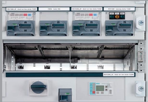
隔室顶部的小型抽出式单元适配板
