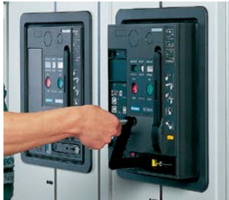
柜门关闭时，断路器可可靠的移动。
