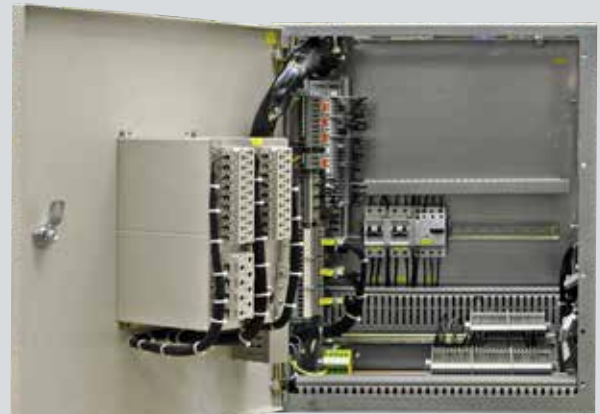
打开的低压室, 带内置设备 (可选)
