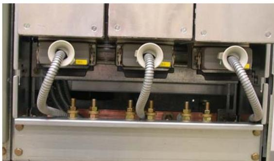
✓ 此时，电压互感器已连接到电缆馈线端。
