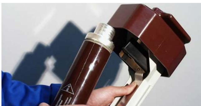
⇒ 将新的高压HRC熔断体装入接触弹簧中，注意撞针位置。高压HRC熔断体上的箭头应指向护盖。
