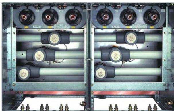
图 8: 母线接头 (金属盖板已卸下)
